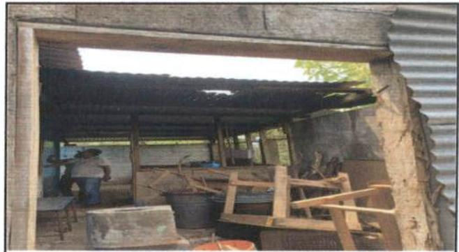
Foto 4: Estructura de cocina, Cambio de lamina y poner puerta de metal
